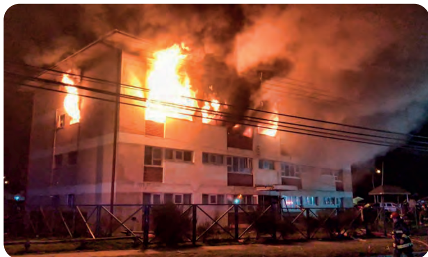
Fotografía: incendio de edificio de departamentos. Punta Arenas (2023).
