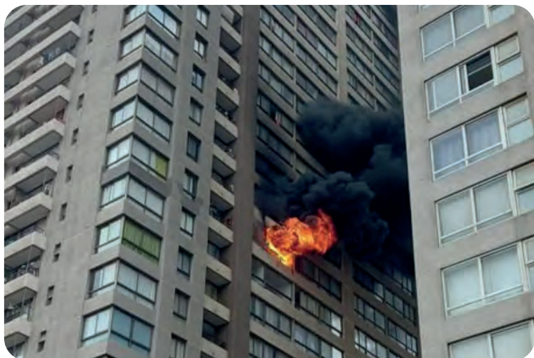
Fotografía: incendio en edificio de departamentos, Santiago (2023).
