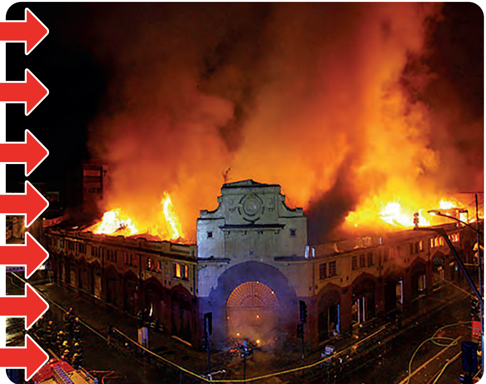
Fotografía: incendio en el Mercado Municipal de Temuco (2016).
